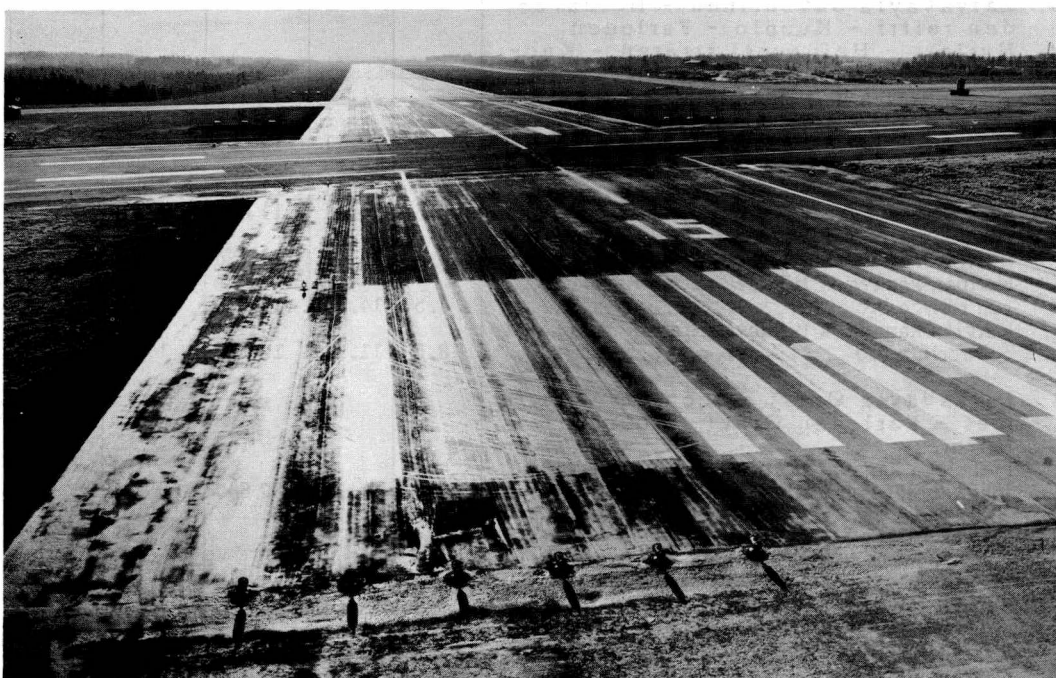
Helsingin lentoaseman pääkiitotien koillisjatkkeen valmistuttua tulee pääkiitotien pituudeksi 3 200 m. Kuvassa oleva 2 250 m:n pituinen ja 60 m:n levyinen sivukiitotie on päällystetty 5 cm vahvuisella avoimella asfalttibetonipäällysteellä, joka on väliaikaisesti tiivistetty tervalietepintakäsittelyllä. Kokonaisrakennevahvuus on 40 .... 130 cm pohjamaasta riippuen. När den nordöstrliga förlängningen av Helsingfors flygstations huvudstartbana blir färdig skall huvudstartbanans längd vara 3 200 m. Den 2 250 m långa och 60 m breda bstartbanan (i bilden) har belagts med 5 cm tjock öppen asfaltbetongbeläggning, vilken tillfälligt har tätats med tjärslamytbehandling. Total konstruktionstjocklek är 40 ..... 130 cm beroende på undergrund.
