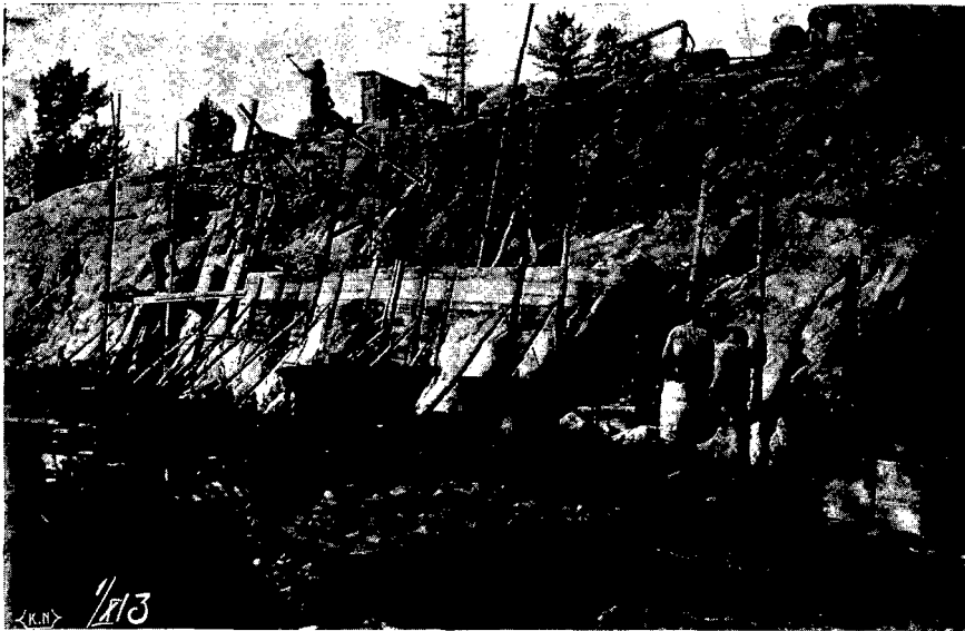
Juojärven—Varislahden kanavaosa. Betonimuurien valmistus.
