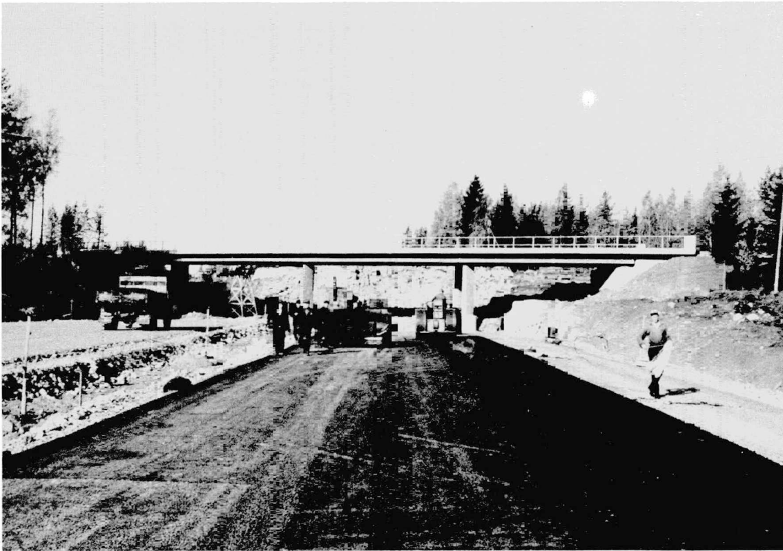
Gumböle - Veikkola moottoritien kantavan kerroksen rakentaminen käynnissä lokakuussa 1966. Helsinki - Turku valtatie johdetan taustalla näkyvän sillan kautta moottoritien yl - Gumböle - Veikkola motorvägbygge, oktober 1966. Byggande av bärlagret är i gång. Huvudvägen Helsingfors - Åbo leds över motorvägen genom broar, som syns i bakgrunden.
