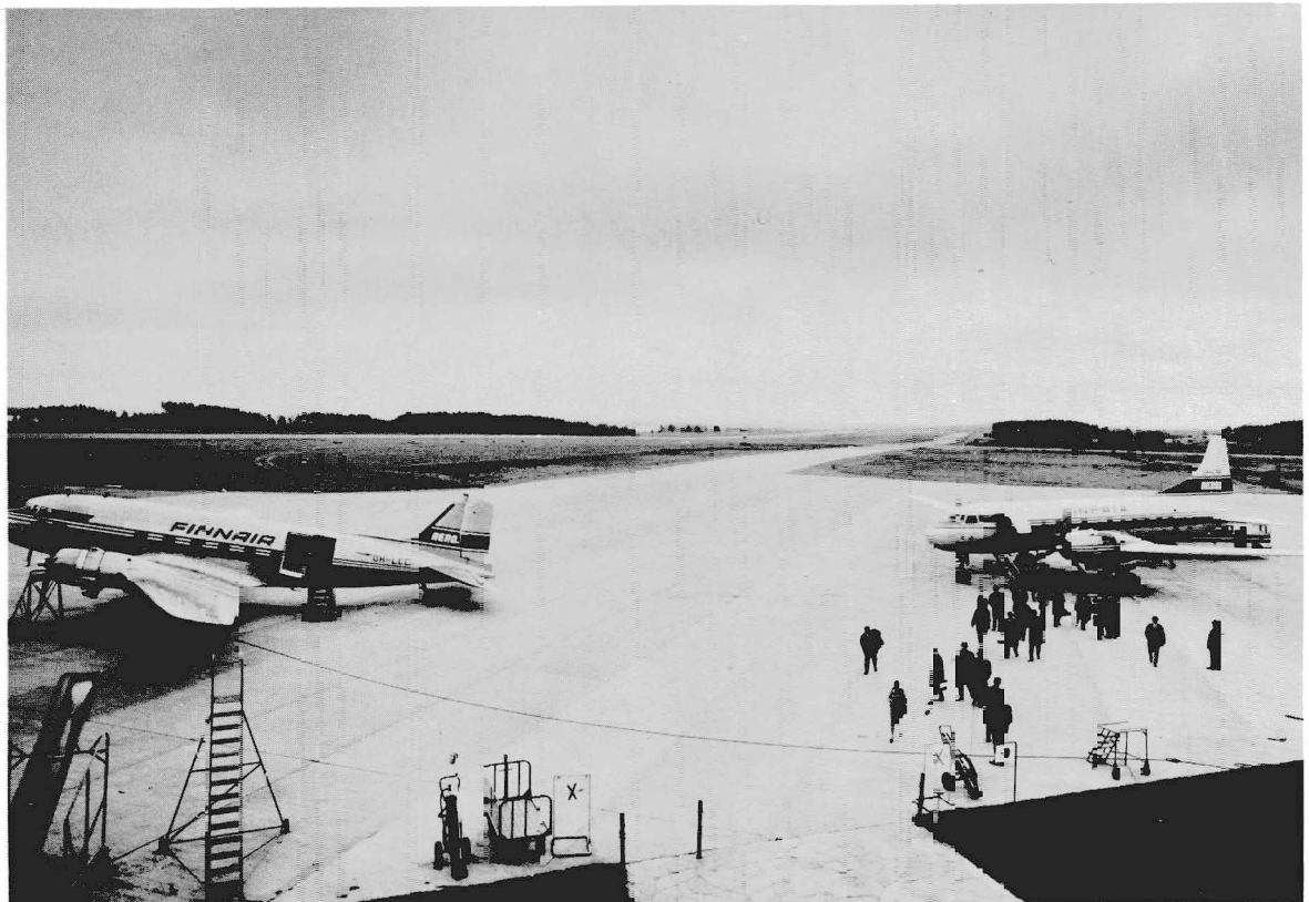
Kuopion lentokentän n. 20 000 m 2 :n laajuinen asemataso kestopäällysteellä I rakennusvaiheessa 18 cm vahvuisella sementtibetripäällysteellä. Laattakoko 3,75 m x 12,5 m - Kuopio flygfälts uppställningsplatta som omfattar ca 20 000 m 2 , permanent beläges med 18 cm tjock cementbetongbeläggning i första byggnadskede. Plattstorleker är 3,75 m x 12,5 m.
