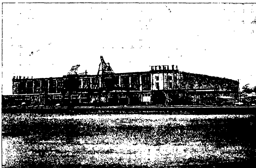
Kuva — Fig. 17. Nuottasaaren uusi tavarasuoja, jonka edustalla asennetaan parhailaan nostokurkia. — Notholmens nya magasin, invid vilket uppmontering av lyftkranar försiggår.
