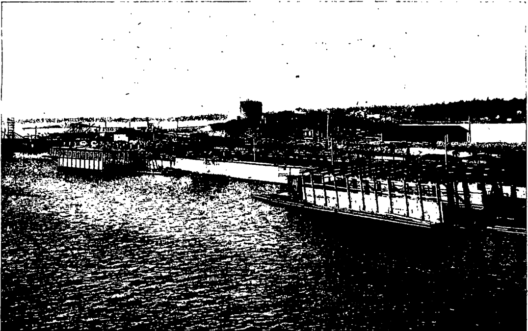
Kuva. — Fig. 14. Osa valmista laituria, jonka edustalla pari uppoarkku telineinen. — Färdigbyggd del av kajen med ett par sänkkistor invid.
