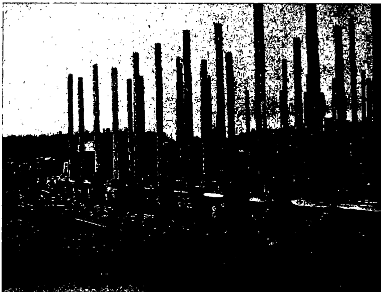
Kuva — Fig. 11. Uppoarkkia salvetaan vedessä, kirvesmiesten työlautat ympärillä. — Sänkkistä timras på vattnet, omgiven av arbetsflotte.
