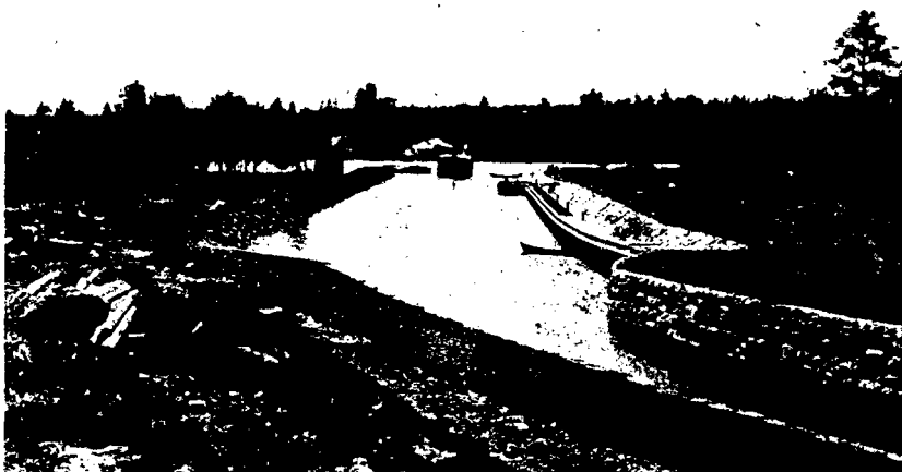
Kuva 5. Varistaipaleen kanavan alaosa valmiina.
