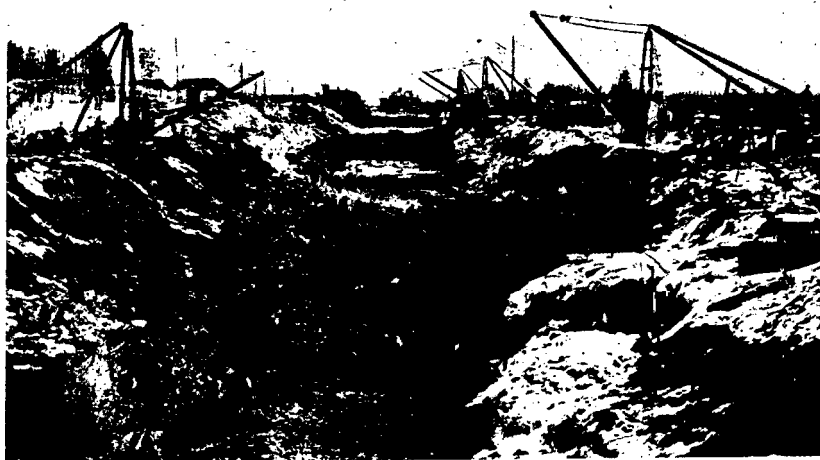
Kuva 10. Varistaipaleen kanava. Louhittua kalliota nostetaan ranojen avulla.
