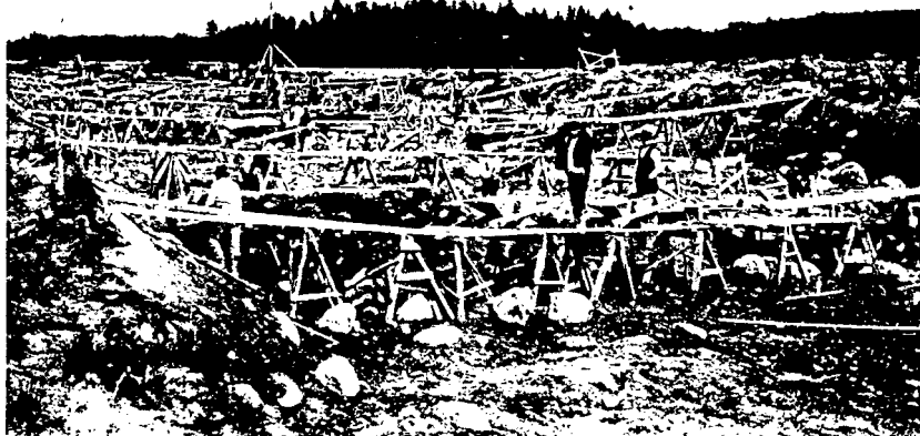
Kuva 8. Varistaipaleen kanava. Maata kaivetaan.
