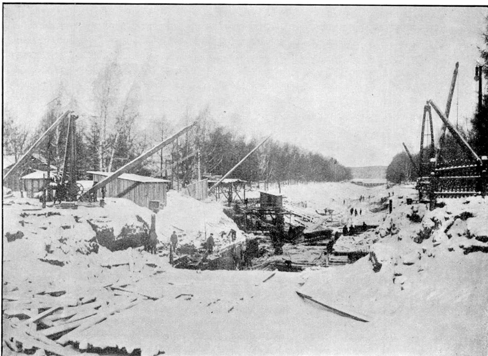
Nedrifning af den gamla slussen.
