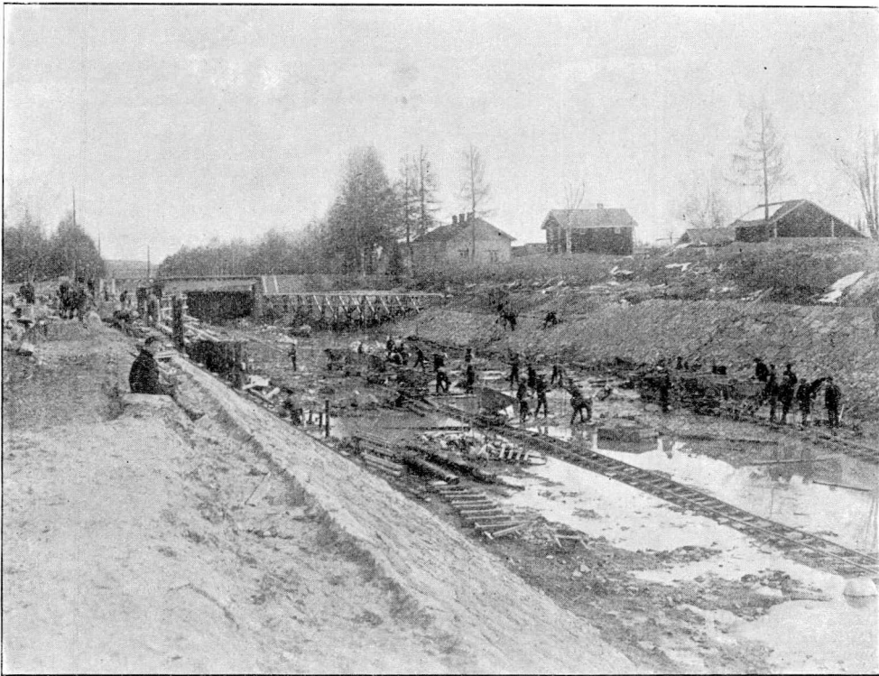
Utgräfnig och revetering af kanalen ofvanom slussen.
