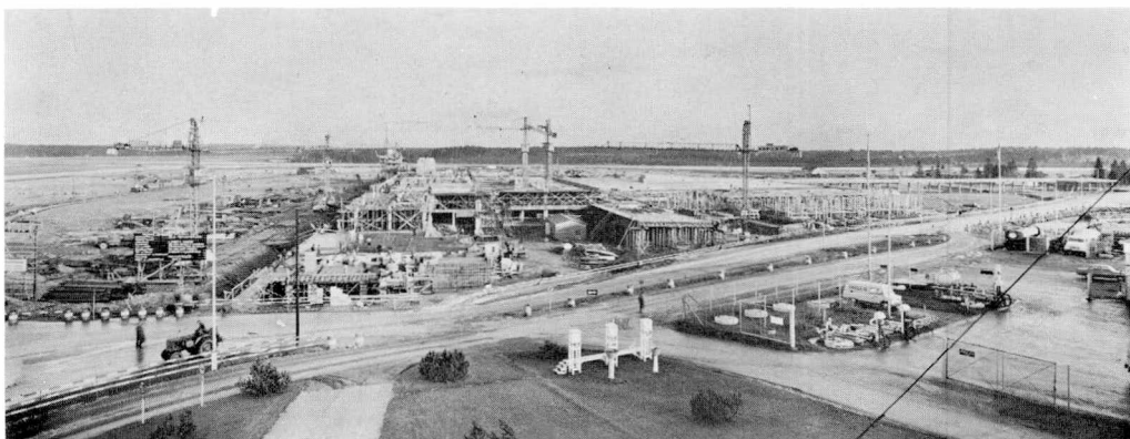
Helsingin uuden lentoasemarakennuksen I rakennusvaiheen kokonais- tilavuus on n. 129 800 m 3 . Rakennuksen edustalle on suunniteltu paikoitustilaa n. 1 500 autolle. Kuvassa rakennustilanne 6.11.1967 - Totalvolymen för Helsingfors nya flygstations I byggnadsskede är ung. 129 800 m 3 . Framför byggnaden har planerats parkeringsutrymme för ung. 1 500 fordon. Bilden visar byggnadssituationen 6.11.1967
