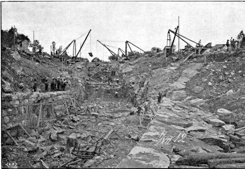
Utsprängning af berg för slussarna vid Varistaipale kanalsträcka.
