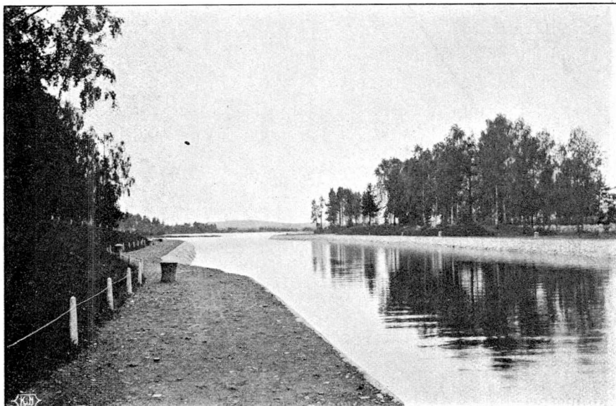
Mynningen af Taipale kanals nedre del.
